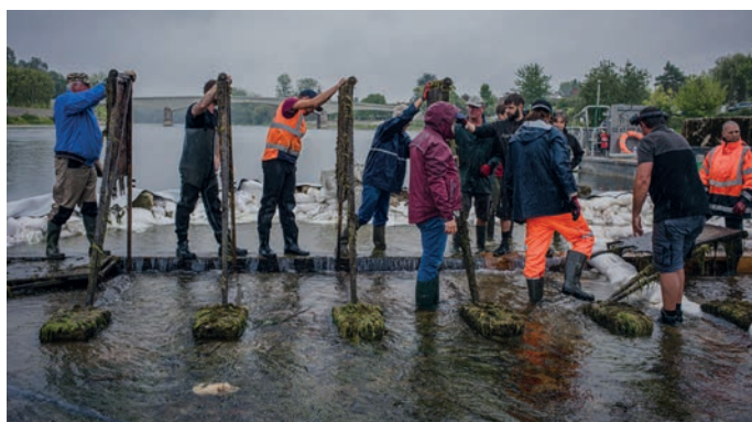
Réparation à Chissay (© Yoän Yager)
