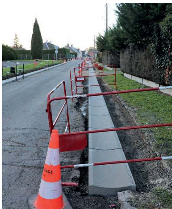
Installation de caniveaux rue de la Croix Rouge.
