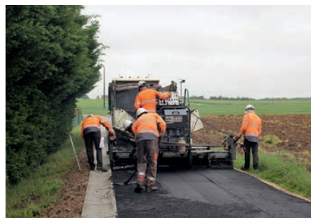
Réfection de la rue de l'Étang Neuf.
