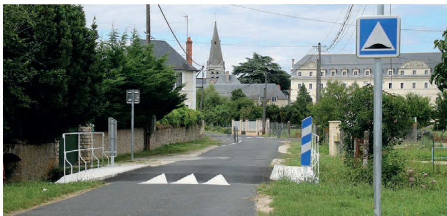
Sécurisation de la rue de la Grefferie.
