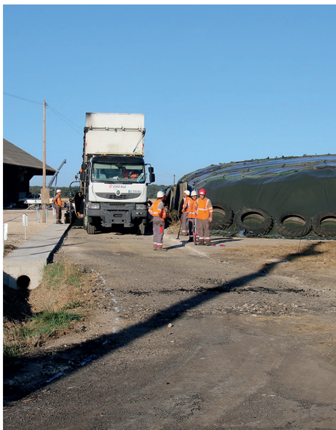
Travaux à l'Imbert.
