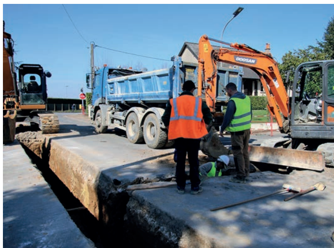
Canalisations route de Bourré.
