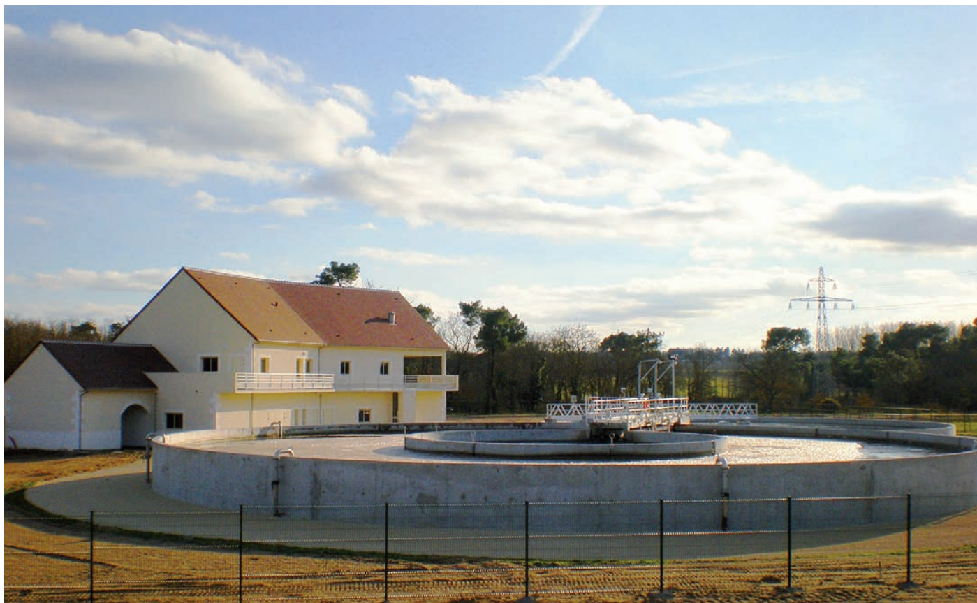
La station d'épuration de Chissay-en-Touraine
