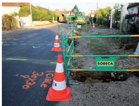
Route de Bourré - Préparation à l'enfouissement des réseaux aériens.
