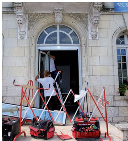
Une porte à ouverture automatique pour la mairie.
