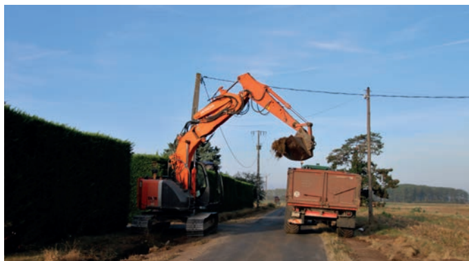
Entretien des fossés rue du Pin.
