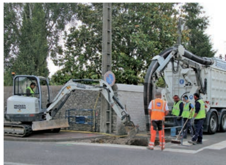
Remplacement des vannes du circuit d'adduction d'eau
