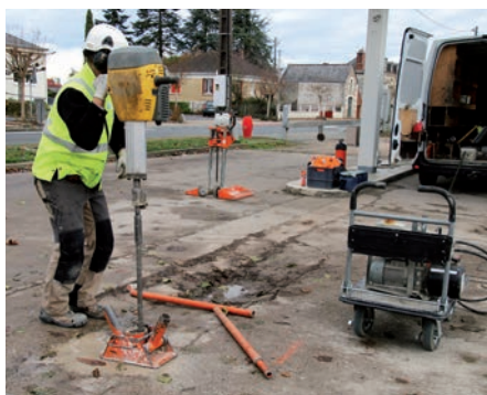
Station-service - Contrôle pollution du terrain.
